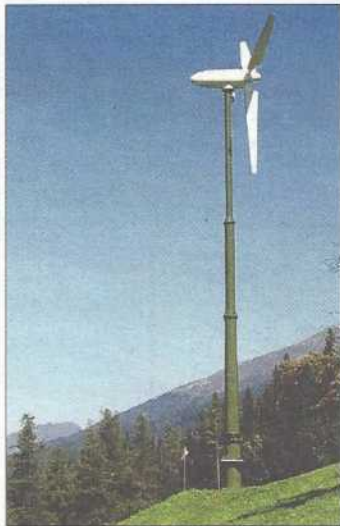
Mit Unterstützung der KEM Lieser-Maltatal wurde am Katschberg schon 2016 ein Windrad errichtet.
