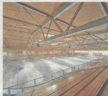
Die Eishalle liefert künftig Sonnenstrom. Foto: privat
